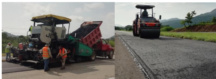
Figura 15. Colocación y compactación de la ultradelgada en Chiapas
