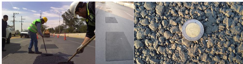
Figura 13. Aplicación de mosaicos y apariencia de Ultradelgada
