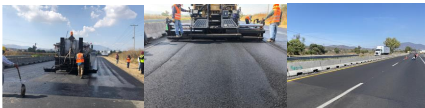
Figura 14. Aplicación de la ultradelgada y apariencia a 1 año
