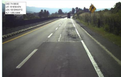
Figura 7. Diferencia en superficie tratada con ultradelgada y sin tratar.
